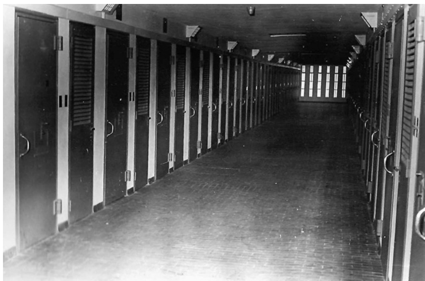
Foto 5. Vista interna de uno de los pabellones de la Unidad 13 de Junín, durante la inauguración, el 18 de abril de 1979.
