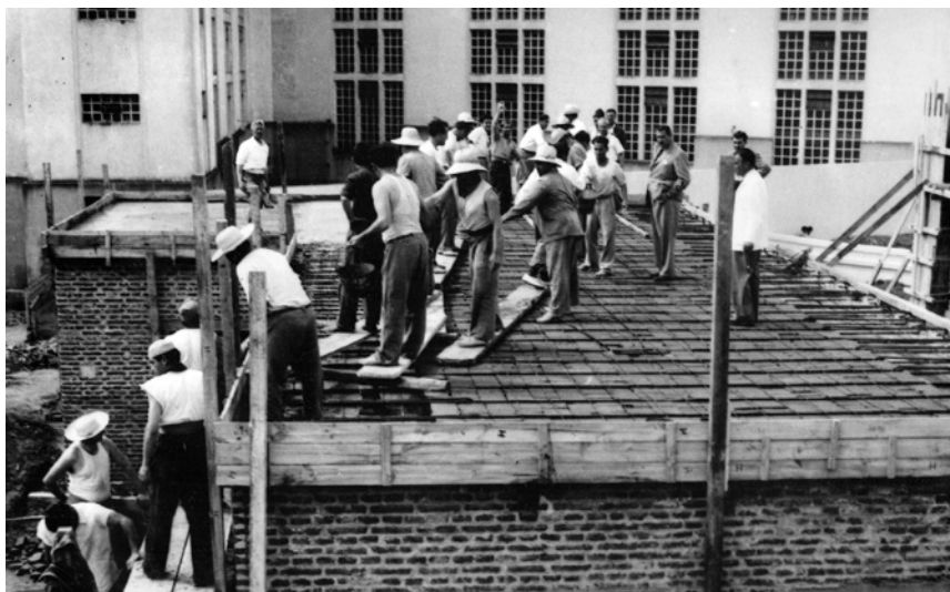
Imagen 11. Construcción de loza. Sector depósito, 13 de octubre de 1954.
