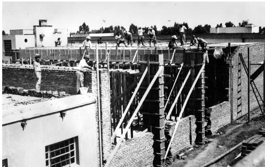
Imagen 12. Preparado de encofrado, 3 de noviembre de 1954.
