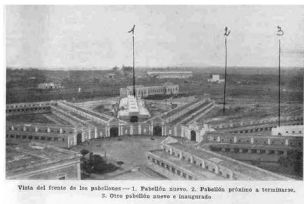
Figura 5. Obras de ampliación en 1937.
